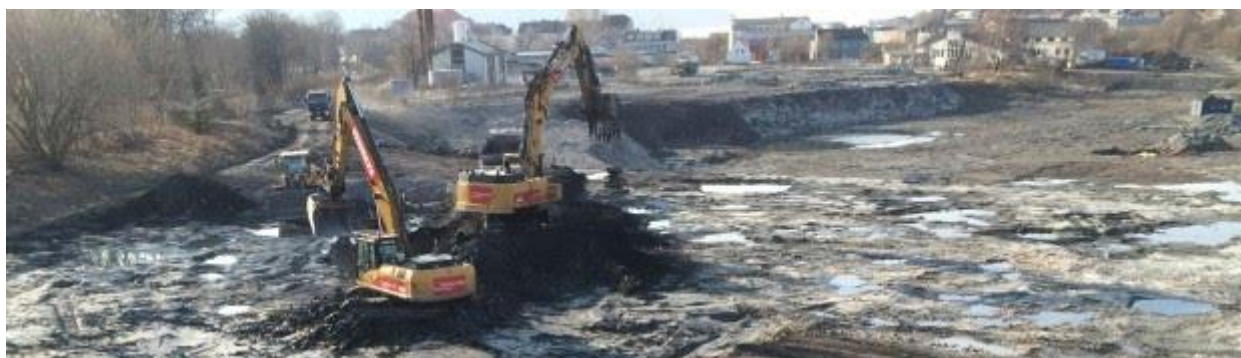
Grunnarbeid på tomten ved tidligere Lilleby smelteverk i Trondheim. Foto: Mette Wanvik.
